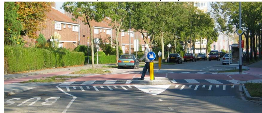
Voorbeeld van een gefaseerde oversteekvoorziening met een fysieke dekking op de President Rooseveltlaan.
