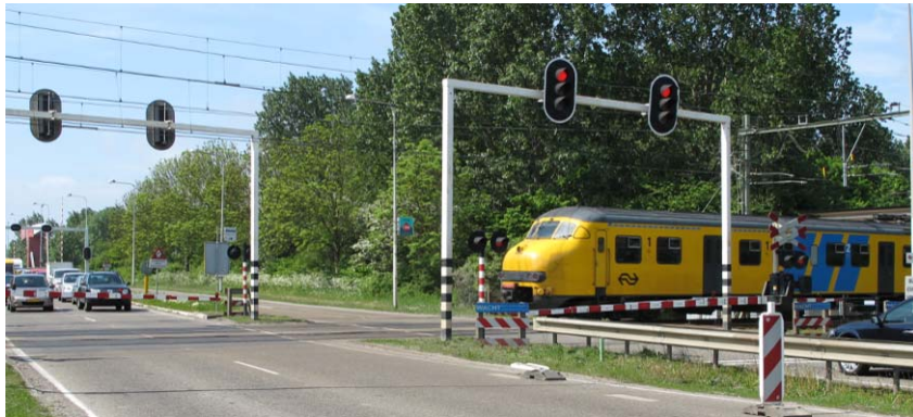
Spoorwegovergang op de Sloeweg, tussen de stations Vlissingen en Vlissingen Souburg
