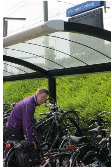
Fietsparkeervoorziening bij station Vlissingen Souburg
